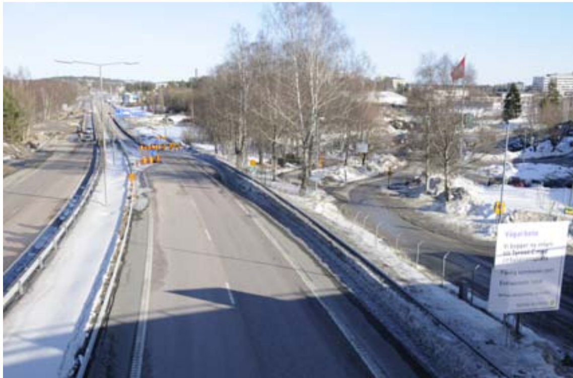
Arbetet med den nya infarten till Tyresö har börjat.
